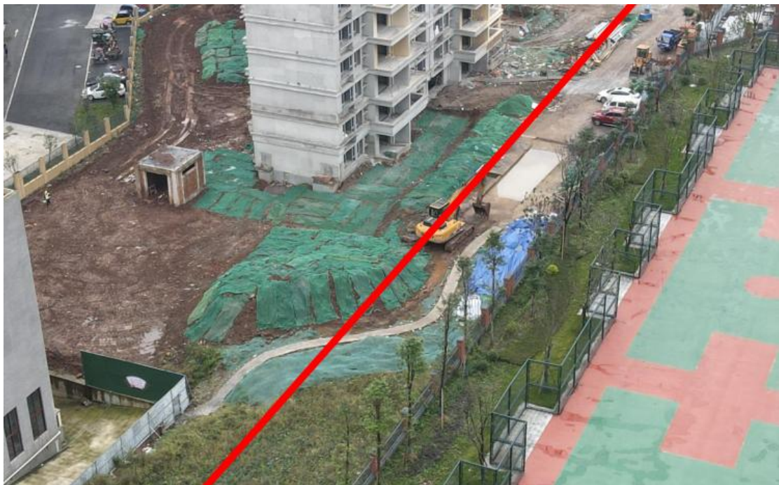
道路施工期间临时堆土及临时苫盖
