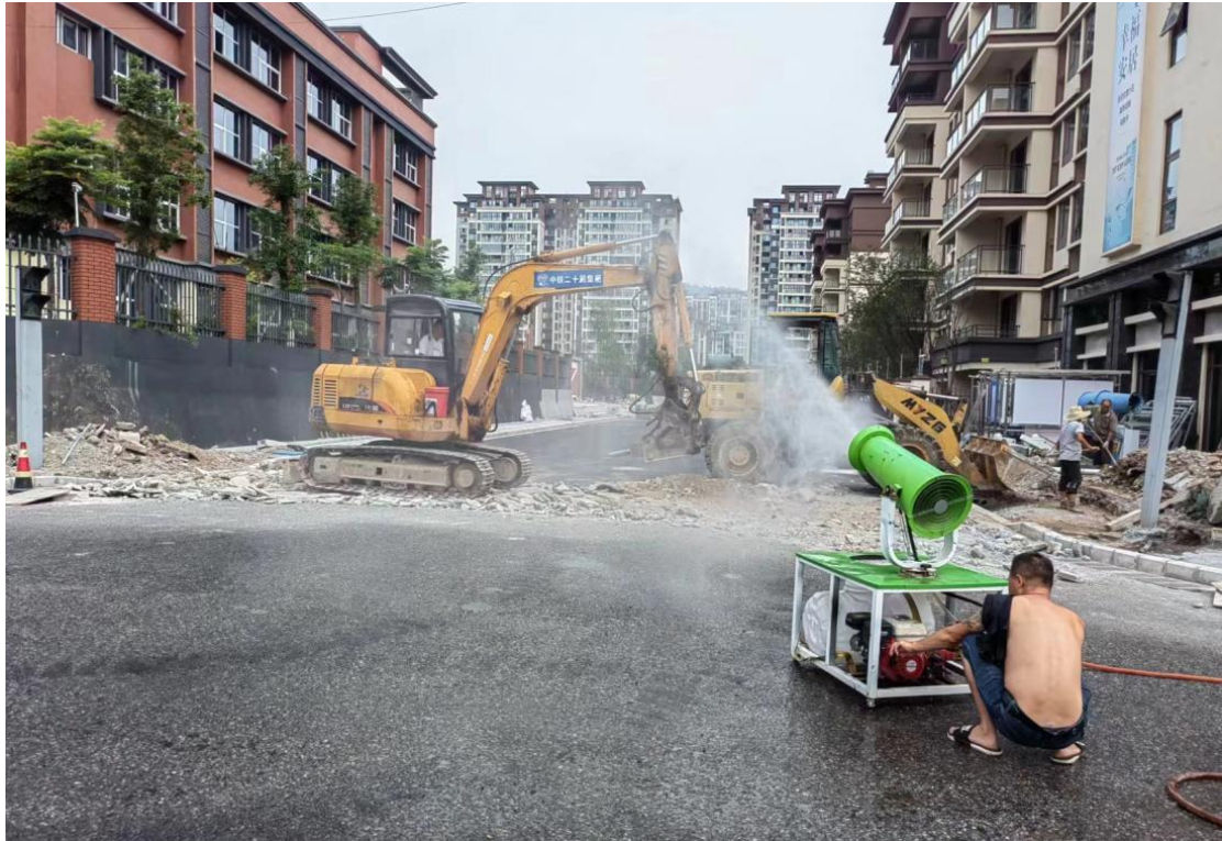
道路施工照片
