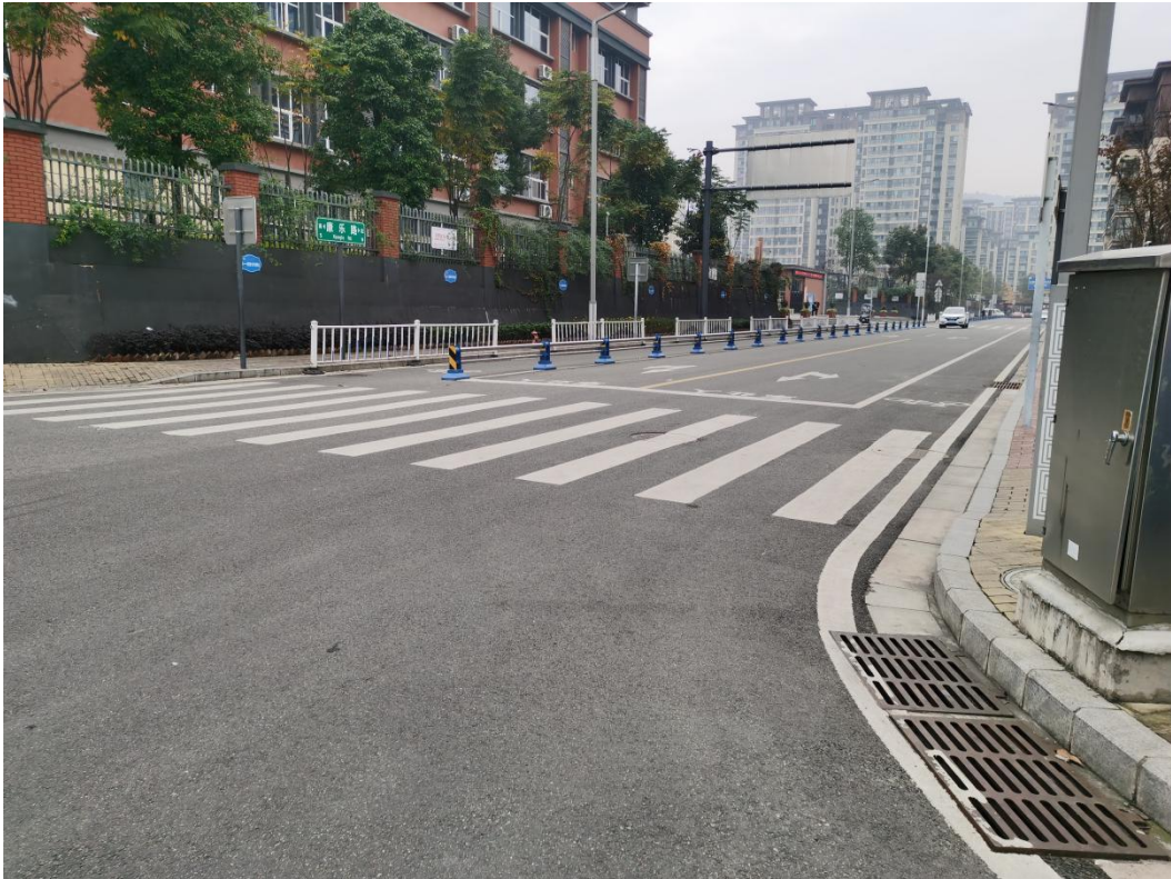
现状道路照片及雨水口
