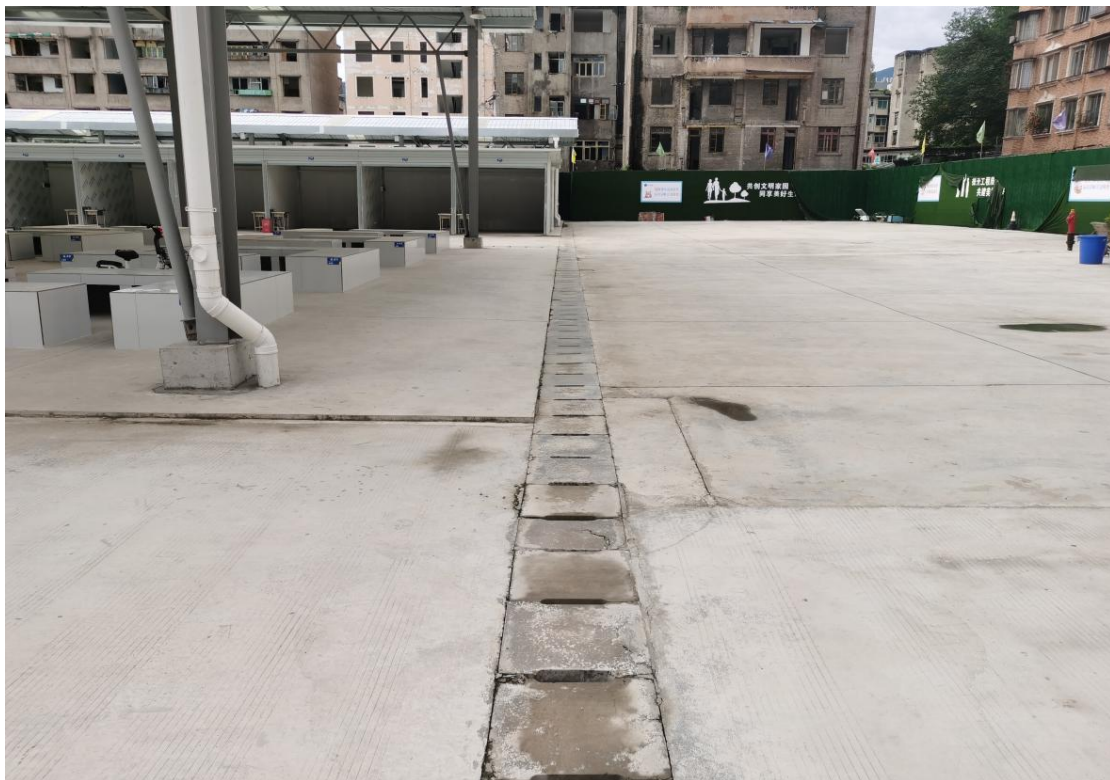
照片 3: 已建排水沟 (一)
