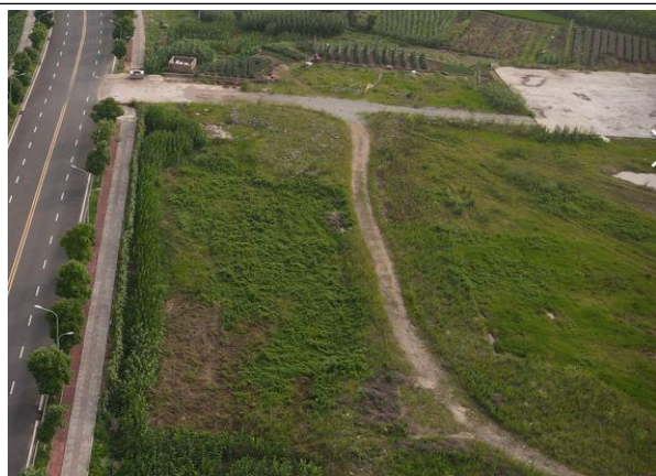
道路工程及施工场地绿化
