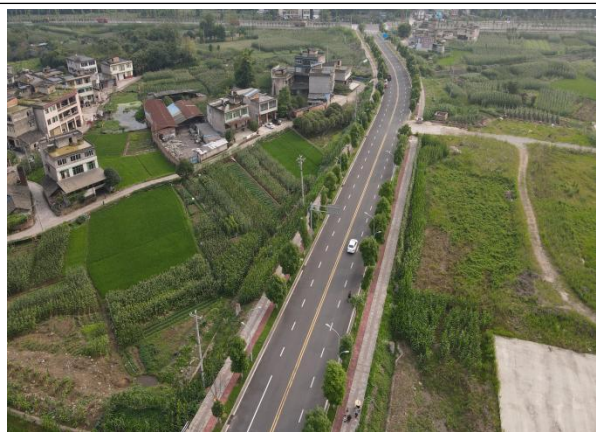
道路工程及施工场地绿化
