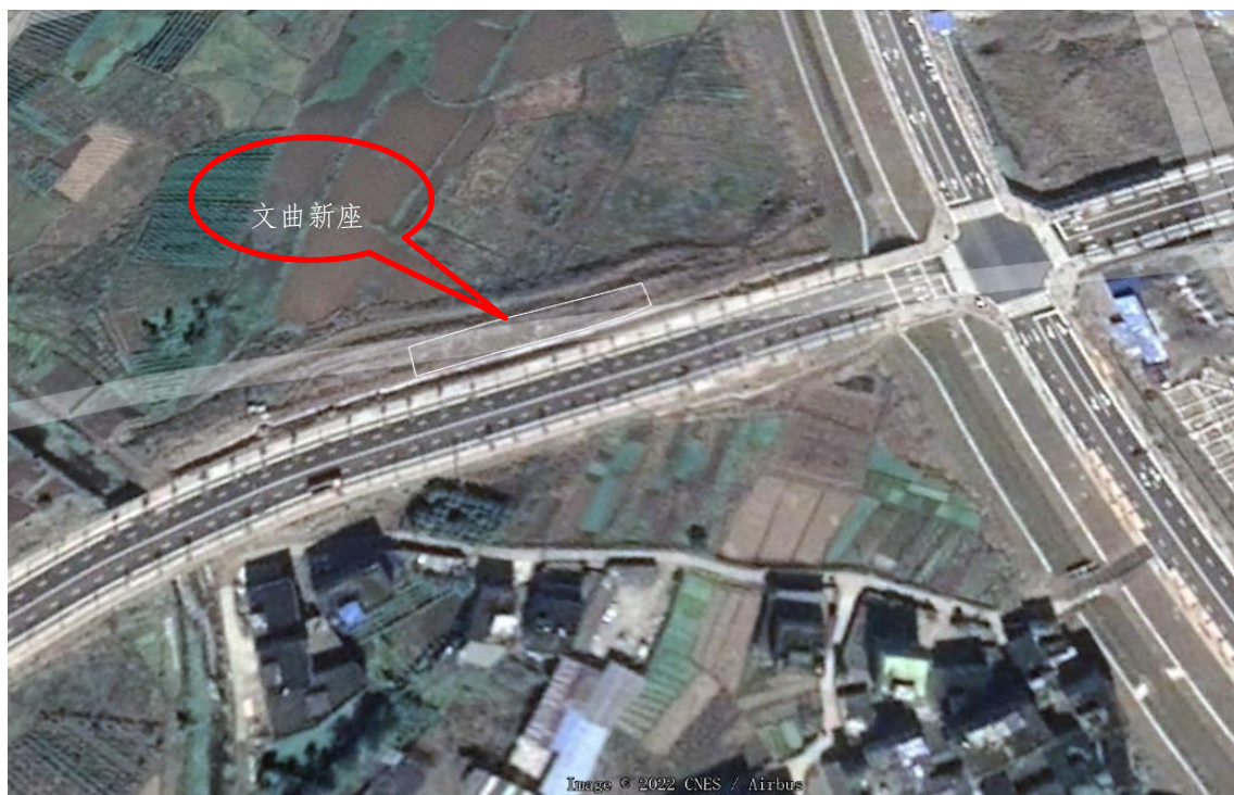
2021 年 7 月施工场地影像图
